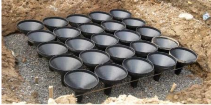
Hình 14. Lắp đặt các khối đã liên kết vào hố móng
