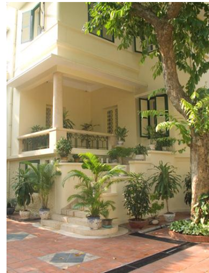
Hình 2. Biệt thự Hà Nội sử dụng tầng 1 để chống ẩm
