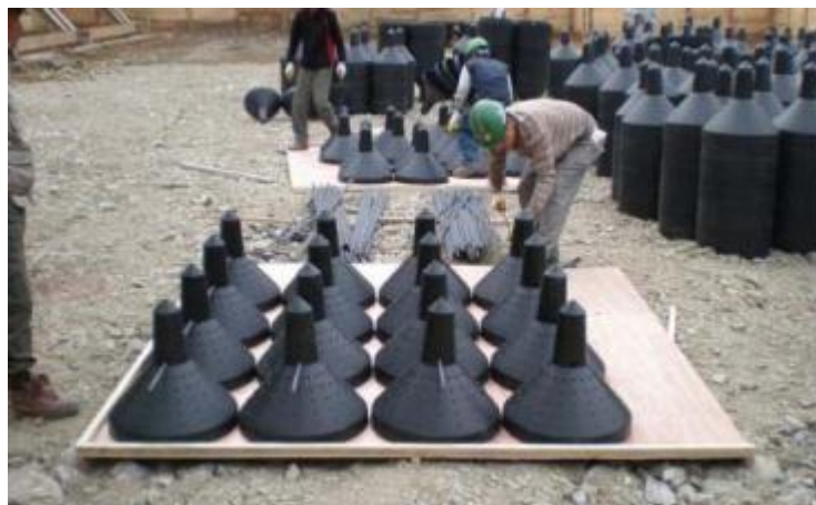
Hình 13. Thi công liên kết các khuôn Top-block thành 1 khối
