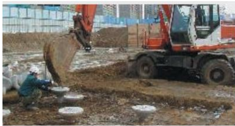
Hình 9. Thi công đóng Top-block
