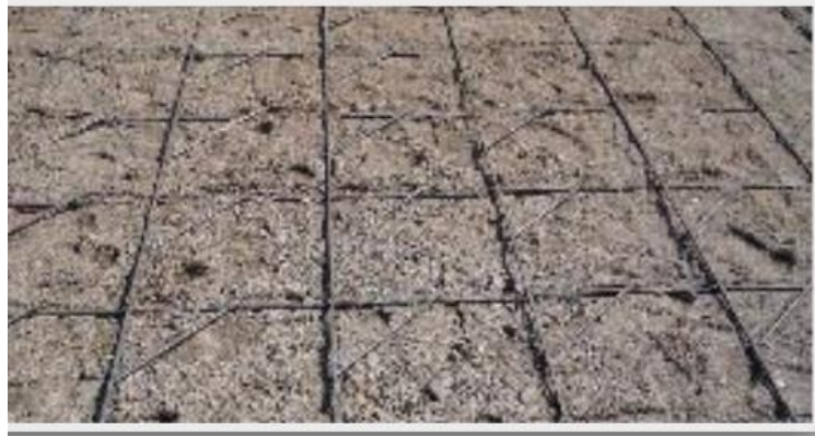
Hình 8. Thi công lưới thép định vị phía dưới
