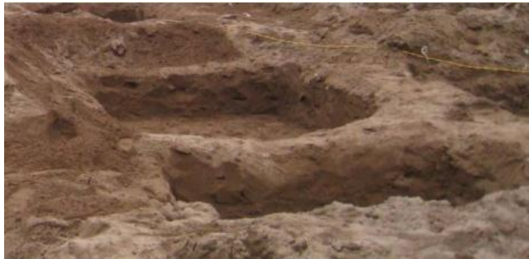
Hình 12. Đào hố móng
