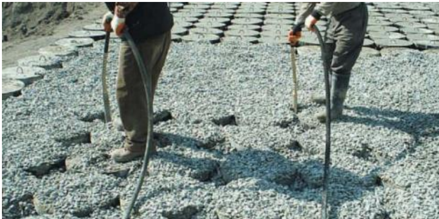
Hình 16. Công tác chèn đá dăm
