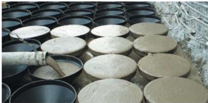
Hình 15. Công tác đổ bê tông tại chỗ các khối Top-block
