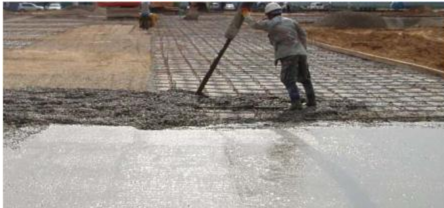
Hình 18. Đổ bê tông lớp mặt (nếu có)
