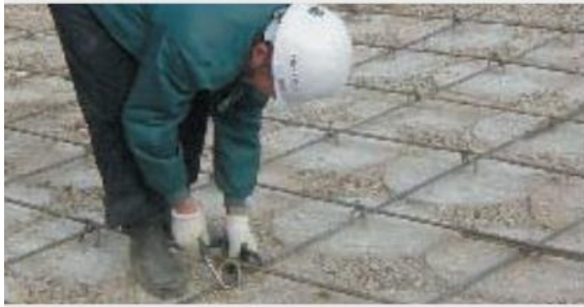
Hình 11. Thi công lưới thép cố định phía trên
