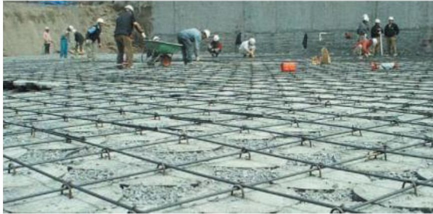
Hình 17 Thi công lớp thép khóa đỉnh
